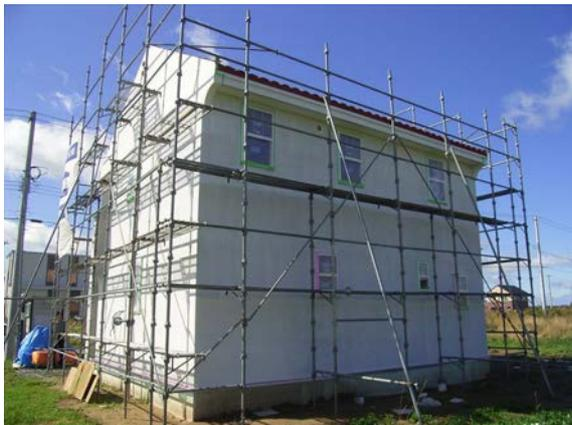
※アクロチョイスにカラーボトルを入れずにセミスムーズ用骨材を入れ塗り付けした状態
