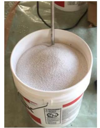
・カラーボトルを混ぜたアクロチョイスのペール缶に骨材を溢れないように入れて下さい。
