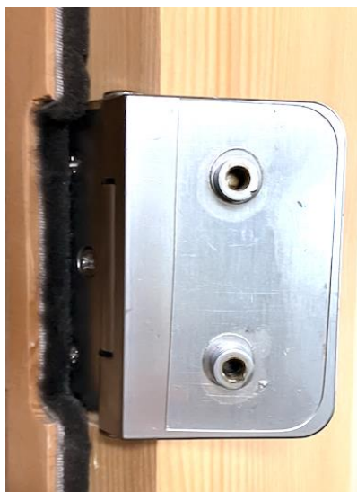
六角ネジを外した枠側のヒンジ
