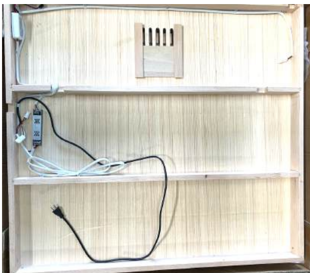
※サウナルームの天井部分 (合板施工前)
