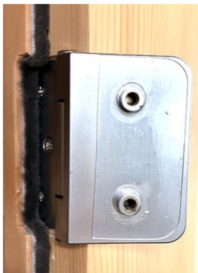
六角ネジを外した枠側のヒンジ
