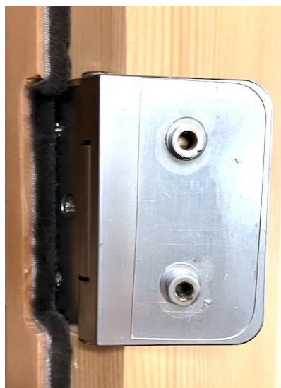
六角ネジを外した枠側のヒンジ
